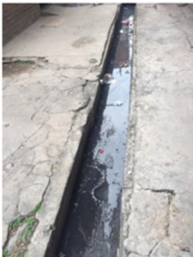
Desagüe pluvial a cielo abierto
