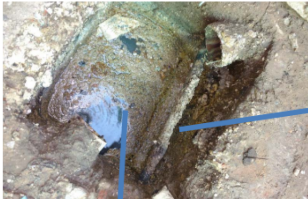
Foto conexión cámara cloacal y servicio de agua
